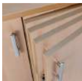
Charnières dotées d'amortisseurs de fermeture
